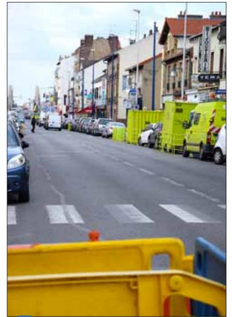
Les travaux de tubage - installation d'un tube neuf dans une canalisation existante - prévus sur la conduite de gaz passant sous l'avenue Marceau pour une durée d'un mois à partir de fin février, ont finalement démarré le 11 avril. Au fur et à mesure de l'avancement du chantier, le stationnement est interdit des deux côtés de la voie.
