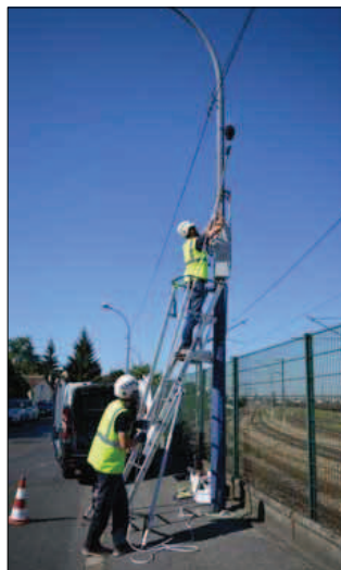
* Installation de la borne de mesure du bruit.
